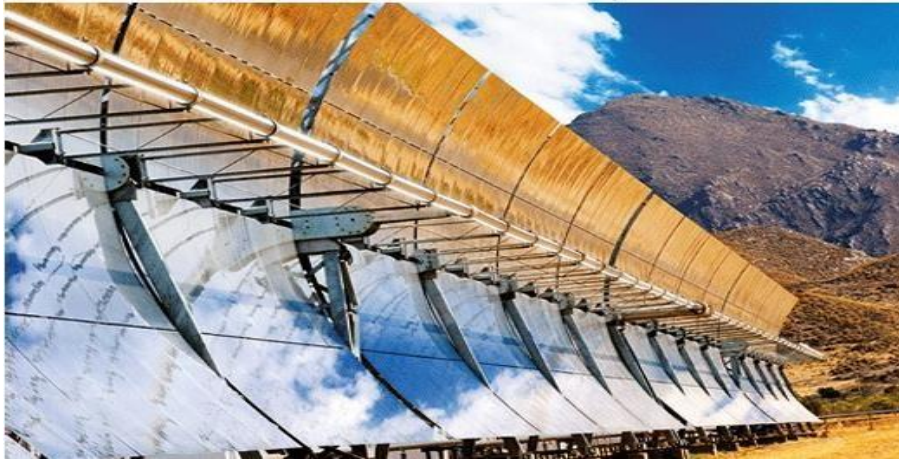
Figure I.4 : Capteurs thermodynamique cylindro- paraboliques
