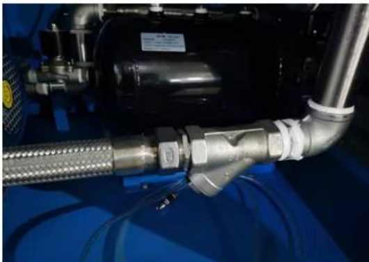
Figure II.12 : Filtre en Y en acier inoxydable [9]
