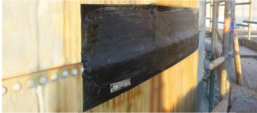
Figure II.2 Réparation composite longue durée pour renforcement de reservoir et cuve sous pression [20]
