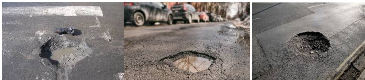
Figure 2.3 nid de poule (a : faible – b : moyen – c : majeur)
