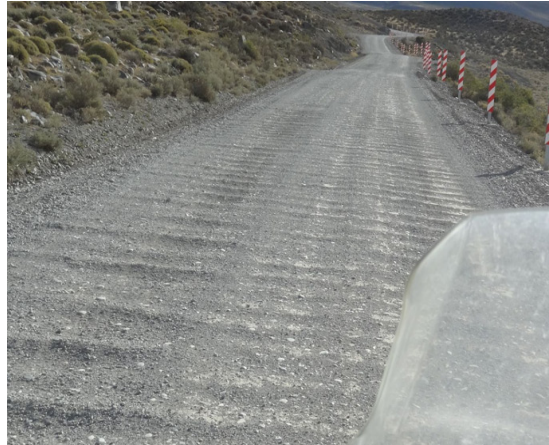
Figure 2.16 tôles ondulée
