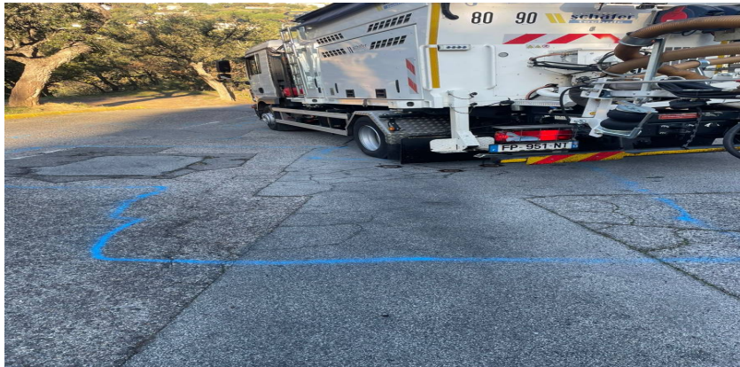
Figure 2.9 Faïençage b- Symptômes annonciateurs
