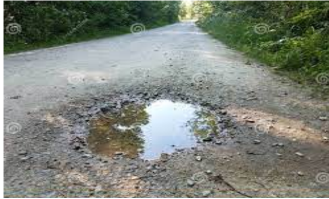
Figure 2.11 Remontées (d'eau ou d'argile)
