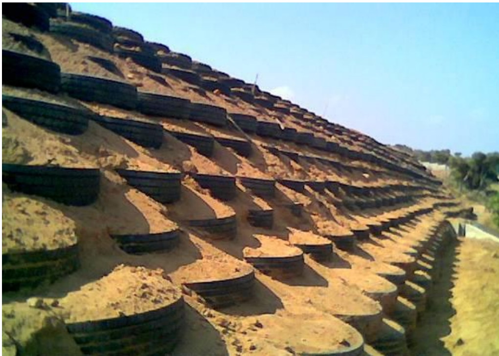
Figure I. 5 : Protection d'un talus par les pneus réformés [10].
