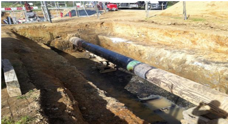
FIGURE 04 : Raccordement d'homogène acier
